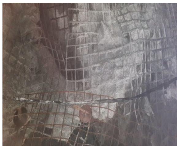
а-металл аркалы; ә-металл аркалы бүрікпебетонмен бірге 2.6 Сурет – Ақбақай кенорнын игеріп жатқан кеніштерде қолданылатын бекітпе түрлері
