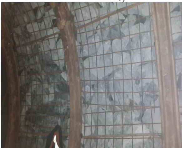
а-металл аркалы; ә-металл аркалы бүрікпебетонмен бірге 2.6 Сурет – Ақбақай кенорнын игеріп жатқан кеніштерде қолданылатын бекітпе түрлері
